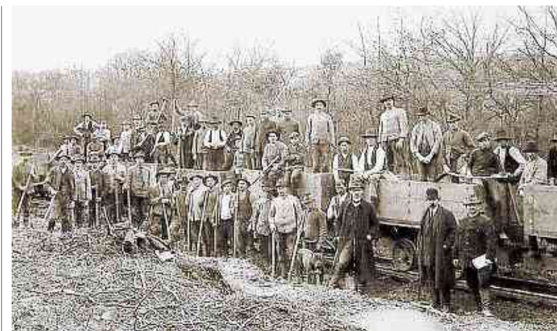
Gewaltige Bauarbeiten waren nötig, bevor die Westerwaldbahn vor 100 Jahren ihren Dienst aufnahm.
