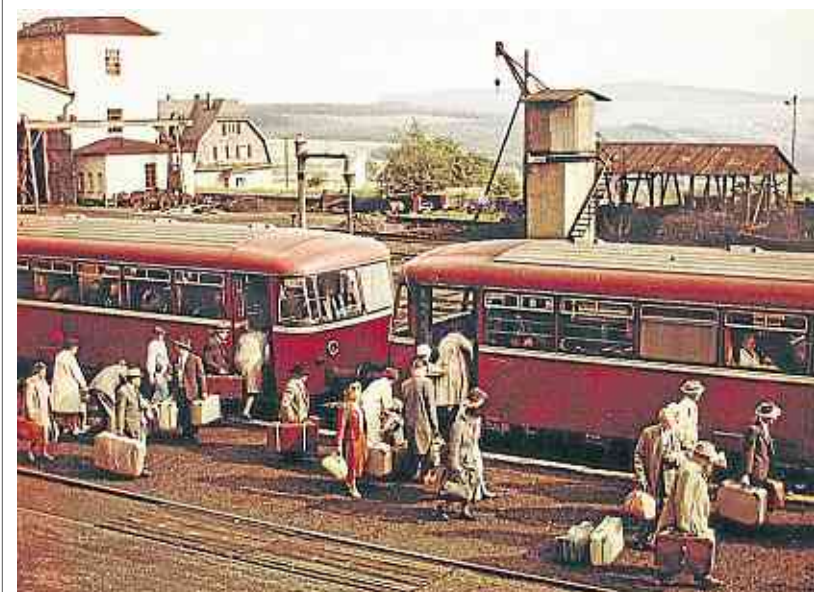
In den 1960er-Jahren kamen viele Feriengäste mit Sonderzügen ins Gebhardshainer Land. „Bitte aussteigen“, hieß es dann im Bahnhof Bindweide.
